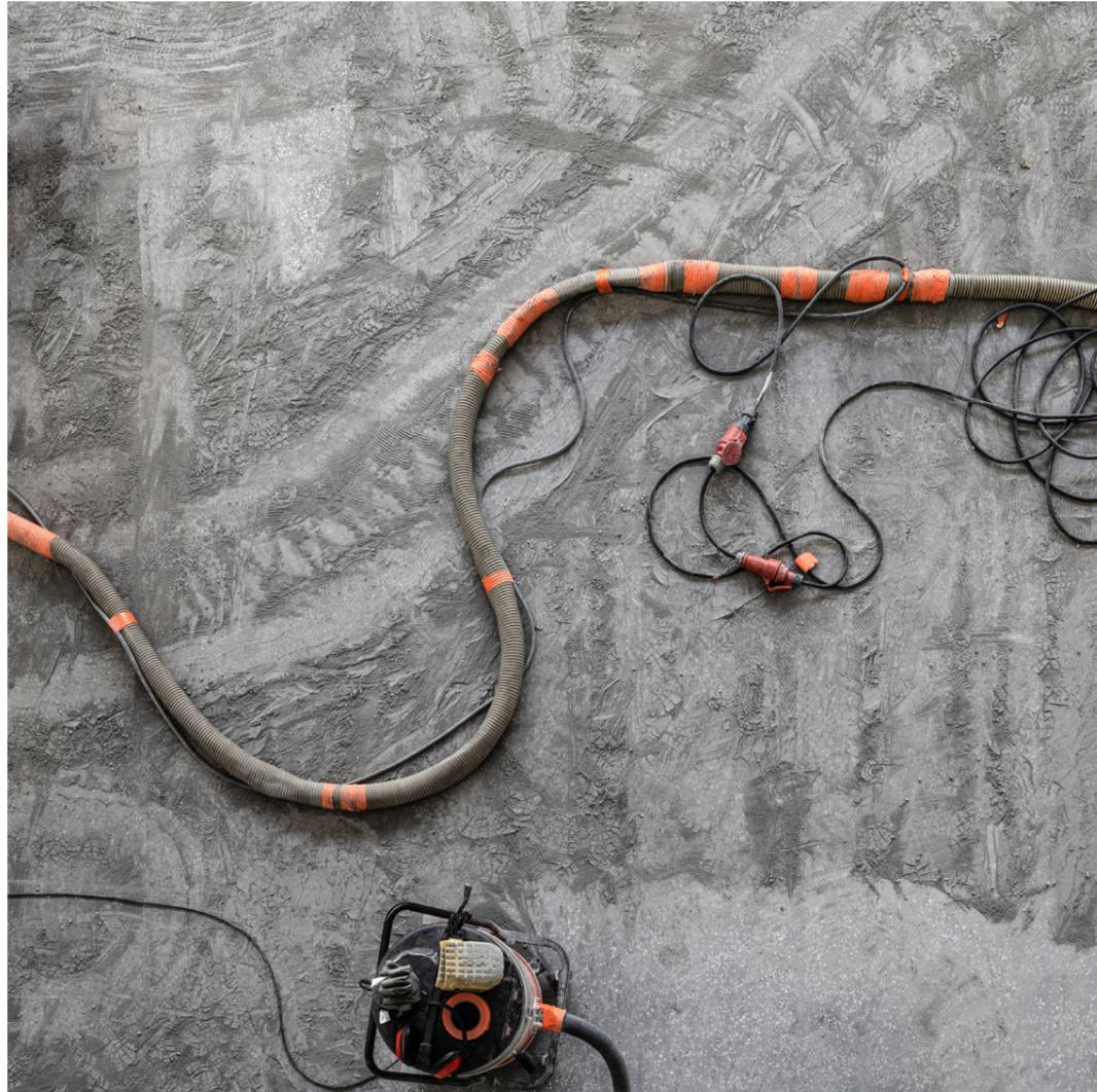
^ Ponçage du terrazzo en 3 passes à sec puis polissage et passage d'un bouche-ports
