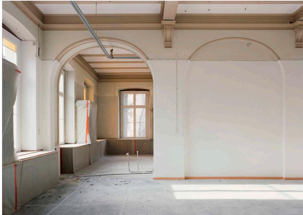
Avant le démarrage du chantier, un travail de relevé minutieux a été réalisé. Chaque espace intérieur a ainsi fait l'objet d'un inventaire détaillé. Les menuiseries remarquables, les parquets, les sols en terrazzo, les modénatures, les garde-corps et les escaliers ont tous été soigneusement photographiés, dessinés et cartographiés. Ce processus permet d'élaborer une réponse de réhabilitation en parfaite cohérence avec les caractéristiques patrimoniales du bâtiment.
